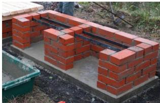
(10) 鉄網の設置 (設置溝：切り欠きの加工)
