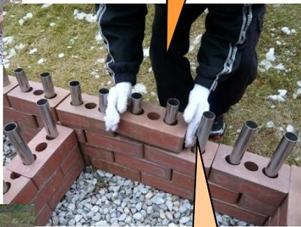
ステンレスパイプの差し込みで一体化
