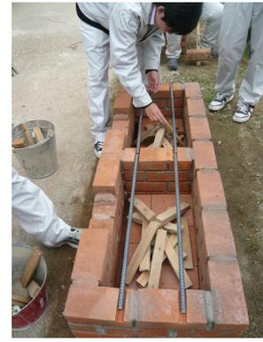
鉄筋を置くだけの様子 (溶接加工なし)
