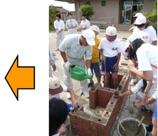
④突き棒などで充填させる
