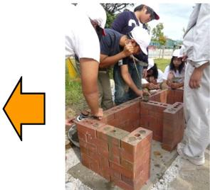
⑤充填させたら上面や側面のモルタルを拭き取る
