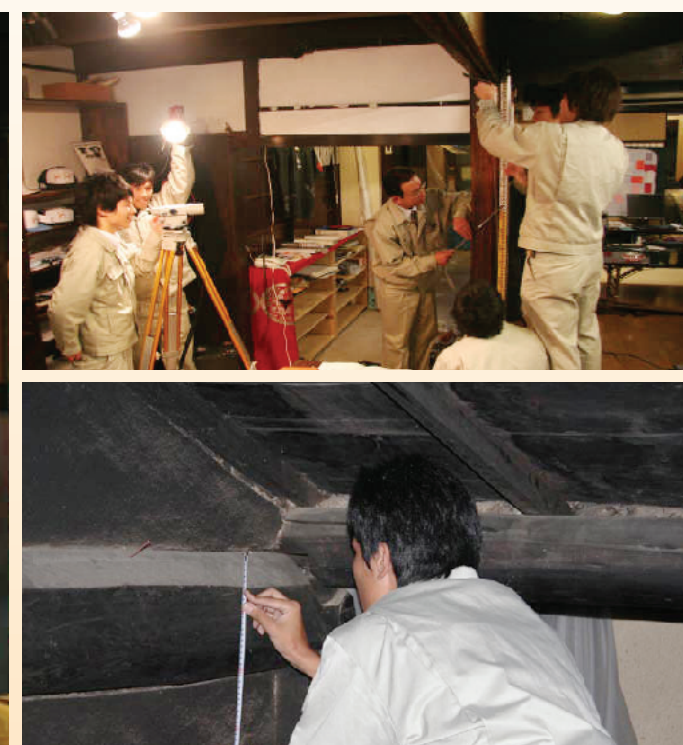
この建物はこれまでの実測に加え、部材寸法、柱の傾き、沈下量も調査した。
