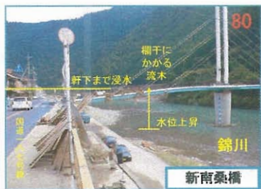
平成17(2005)年台風14号による山口県錦川の洪水災害
